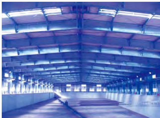
埋立棟内部全景
